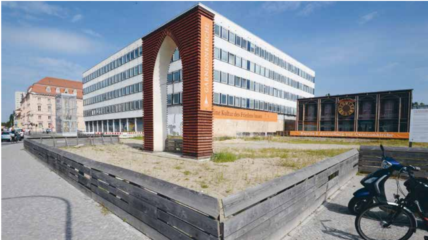
Über diese Geschichte ist noch kein Gras gewachsen: Seit Juni 2011 steht die „Nagelkreuzkapelle“ (im Hintergrund rechts) auf dem Gelände der einstigen Garnisonkirche, ein temporäres Gebäude mit Blick auf freigelegte Fundamente, vorn im Bild erinnert ein gemauerter Gewölbebogen an die zerstörte Kirche.
